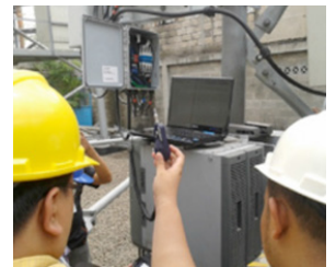
在 RRU 处 (塔结构或屋顶)
